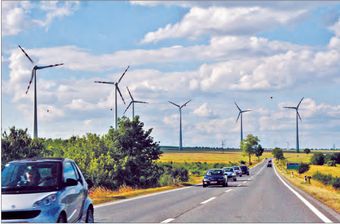
140-metrowe wiatraki staną na wysokości 330 m n.p.m., zatem najwyższe wzniesienie otaczającego je masywu (360 m n.p.m.) przewyższając będą o 100 metrów i będą doskonale widoczne z Prudnika
