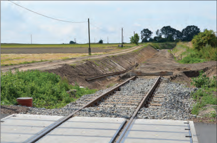
Remontowany odcinek linii kolejowej w Białej
